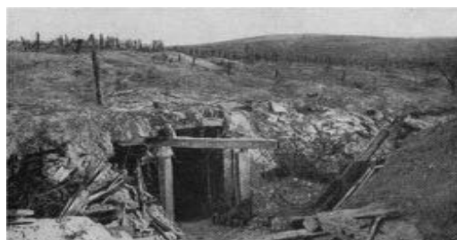
Entrée sud, seul vestige existant du tunnel du mont Cornillet,
