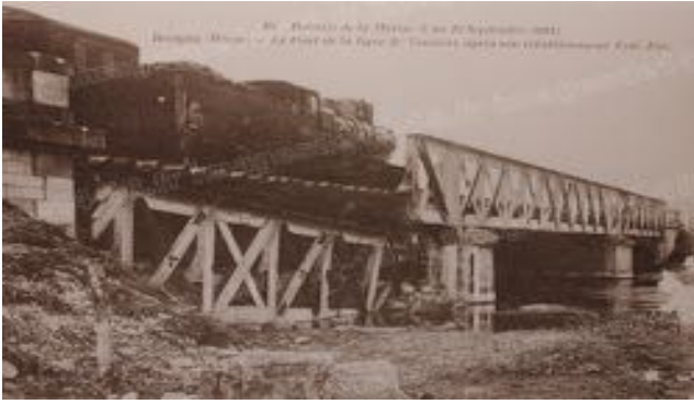
Reconstruction par le Train des Equipages d'un pont ferroviaire sur l'Ornain à Revigny-sur-Ornain (Meuse).
